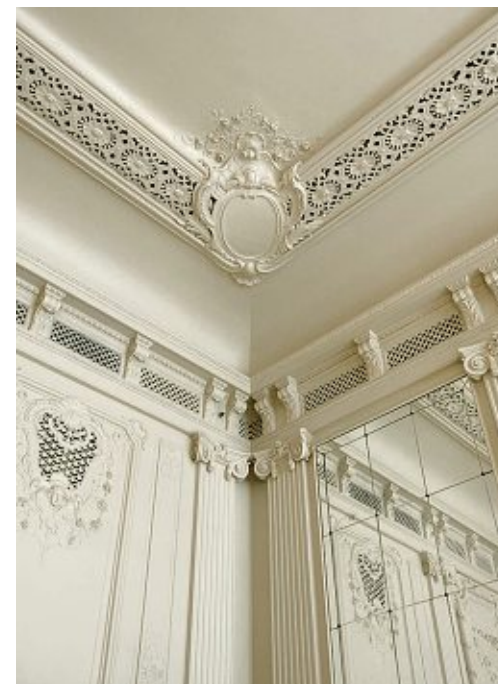
Der Name als Programm: Im „Kaisersaal“ wurden selbst Heizungsgitter reich ornamentiert.
